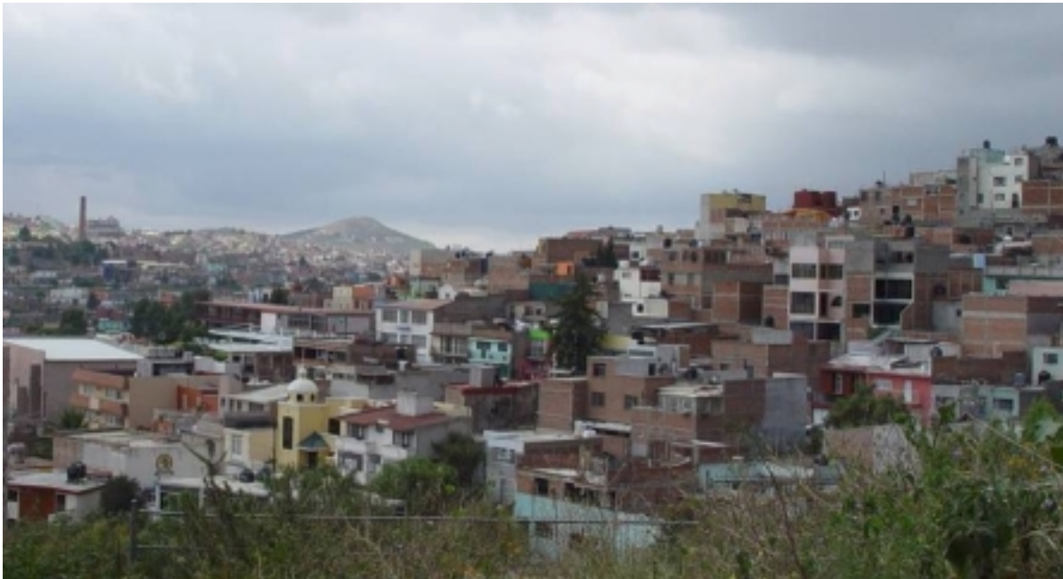
VISTA DESDE EL PASEO DÍAZ ORDÁZ, ALTERACIONES DE LA IMAGEN POR INCREMENTO DESORDENADO DE NIVELES Y COLINDANCIAS SIN ACABADOS
