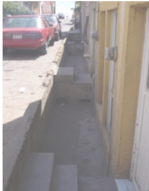
CALLE VENUSTIANO CARRANZA Y PEÑA, ZONA HABITACIONAL CON DRENAJE DE AGUAS PLUVIALES A CIELO ABIERTO
