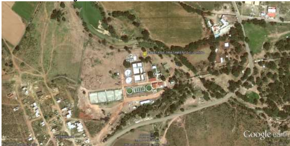
Figura A.V.3. Planta de tratamiento El Orito
