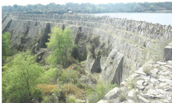
Presa El Salto Villanueva
